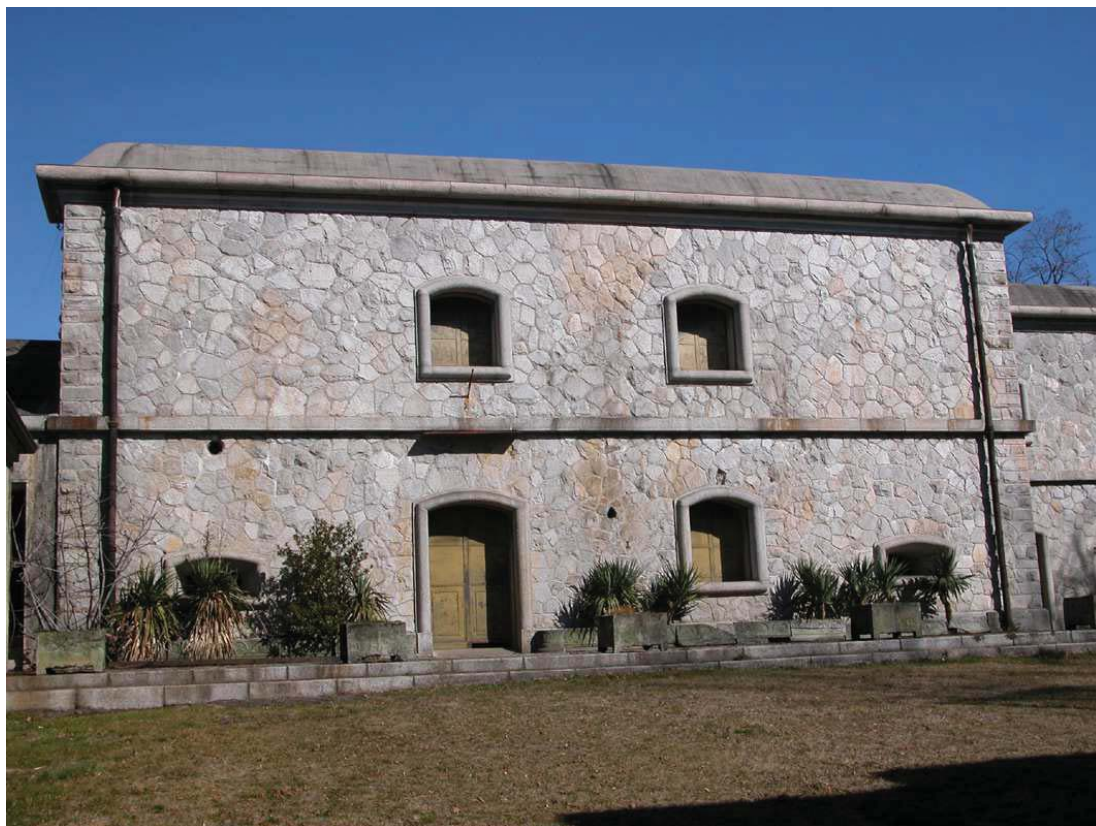
La facciata principale dell'opera con evidenti le particolarità architettoniche in granito
