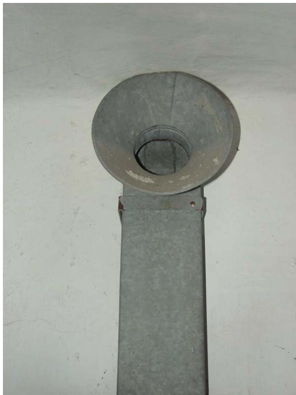
Uno dei numerosi bocchettoni di insufflazione aria pulita.
