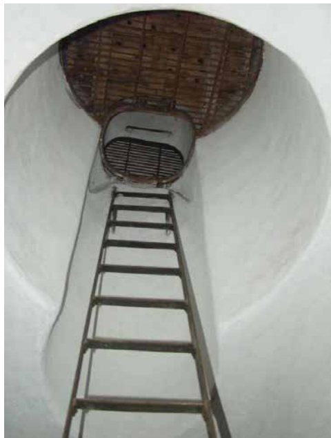
Scaletta di accesso dalla sala comando all'osservatorio posizionato sulla copertura
