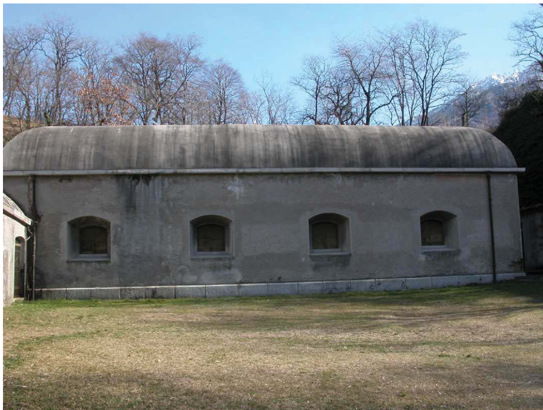
La facciata principale del ricovero alla prova
