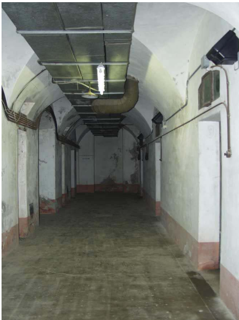
Corridoio al piano terra
